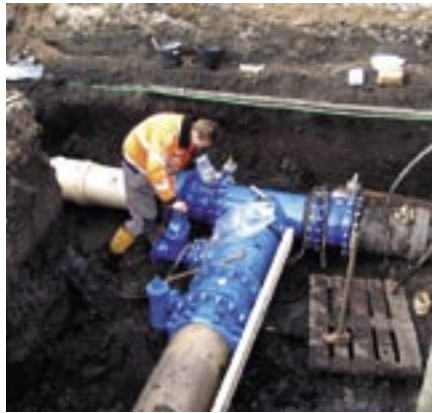
Aansluiting van verschillende materialen (drinkwater)
